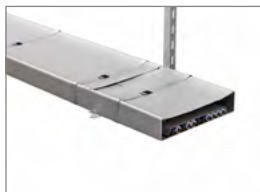
Bandagierung gesamter Kabeltrassen
