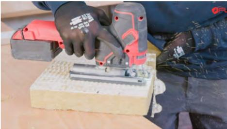
Maße für Plattenzuschnitt nehmen, Schnittlinien anzeichnen und Platten zuschneiden; Ausschnitte für Durchführungen herstellen und einpassen.
