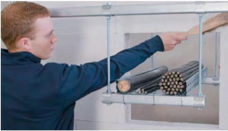
Laibung der Bauteilöffnung und Installationen reinigen und mit Klebeband abkleben.
