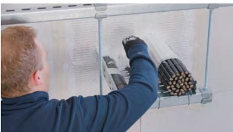
Endanstrich: Kabel je Seite 100 mm vorm Schott und die Schottoberfläche, sowie einen Überstand von 20 mm mit BML beschichten.
