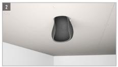
Die Brandschutzhaube muss vorsichtig eingerollt und durch die Konstruktionsöffnung geschoben werden.
