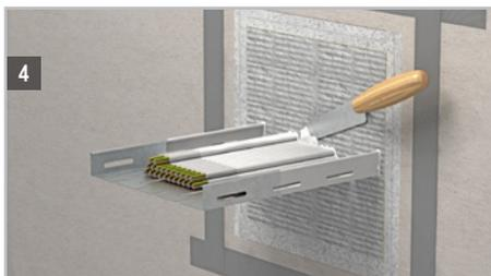
Nach dem Schließen der Bauteilöffnung sind alle Spalten und Fugen jeweils auf der äußeren Seite mit den Ablationsbeschichtungen BMS bzw. BMK flächeneben zu verspachteln.
