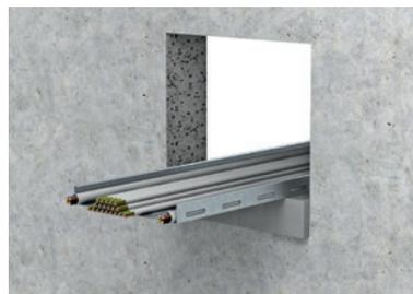
3. Brandschutzsteine passgenau zuschneiden, so dass ein dichter Anschluss an das Bauteil entsteht.
